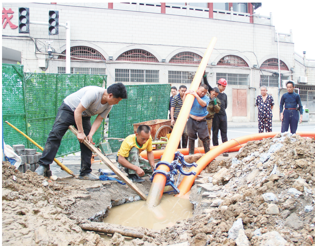
4月12日，市政公司施工人员在资江北路开展电缆管网建设。施工人员用非开挖水平定向钻机打通管道，将两根长100米的拖拉管灌入其中。改造完成后，空中电缆将埋入地下，在美化市容市貌的同时，提高用电安全系数。
