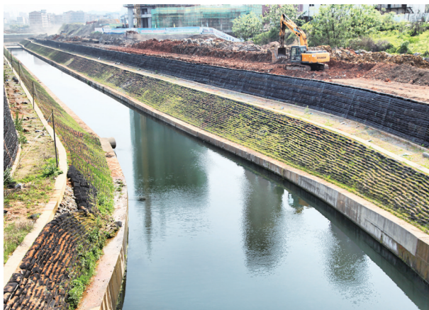
红旗渠风光带在分段施工中
