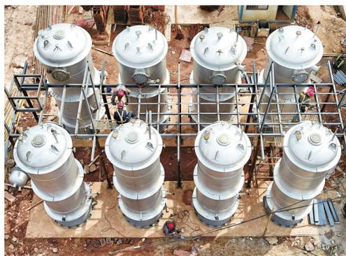
3月28日，市污泥集中处置工程项目在加紧建设中。该项目是我市重点环保工程，近期项目设计处理规模200吨/日。目前，项目设备厌氧反应罐、干化机等已经安装完成，整个工程完成80%，预计今年7月份可以投入试运行。
