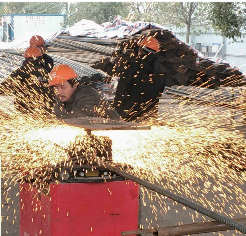
钢筋工正在焊接
