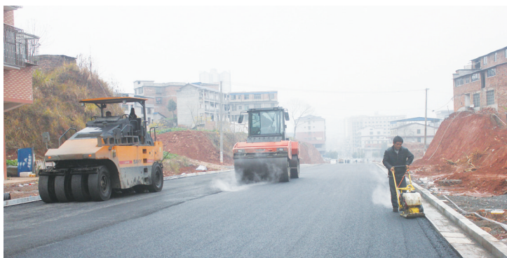
上月30日，大祥区迎春路中段开始摊铺沥青路面。迎春路中段全长680米，路幅12米，双向四车道。该路段拉通后，迎春路（西湖路至雪峰南路）将全线贯通，将有效缓解敏州路和西湖路的交通压力。
