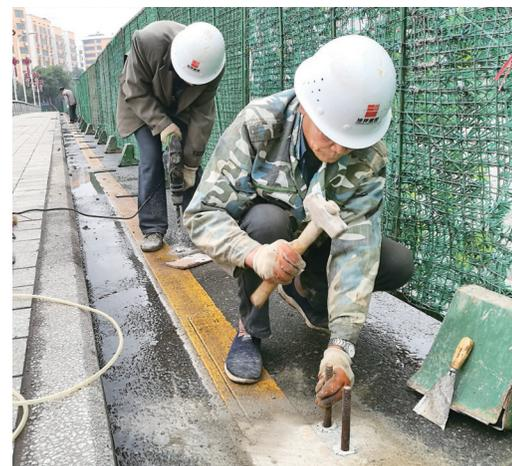
施工人员实施更换护栏前的搭架作业。
