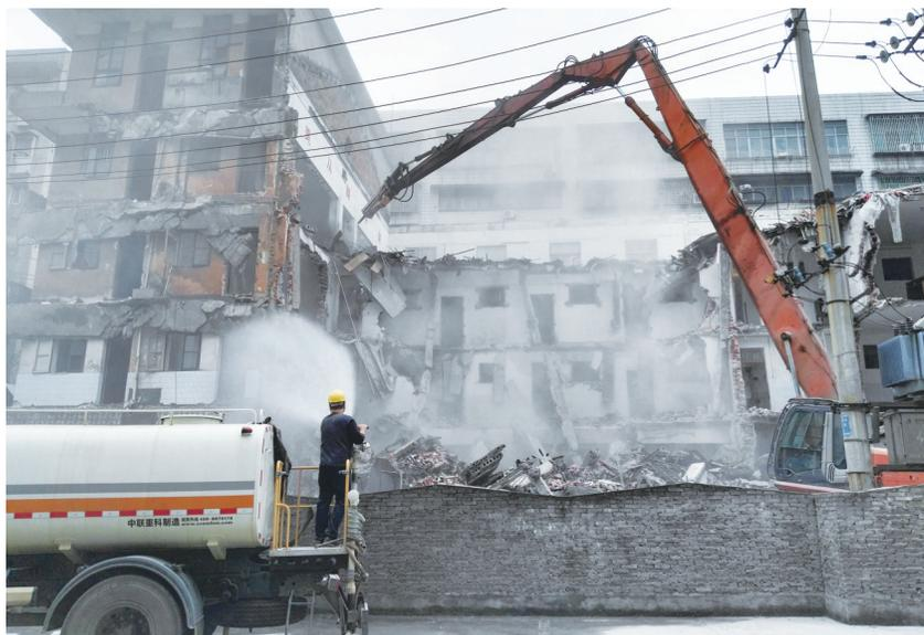
拆除现场,洒水车和挖掘机同时作业,降尘效果较好。 伍洁 摄
