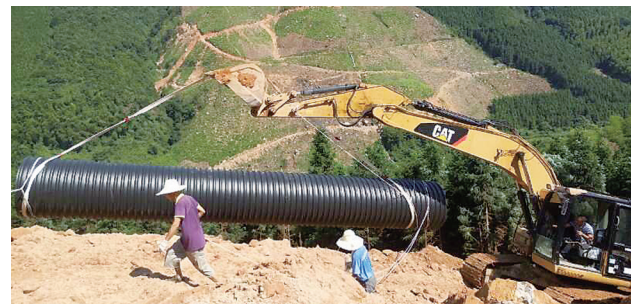
首战洛口山时翻山越岭运输1.2米口径的钢带波纹管。
