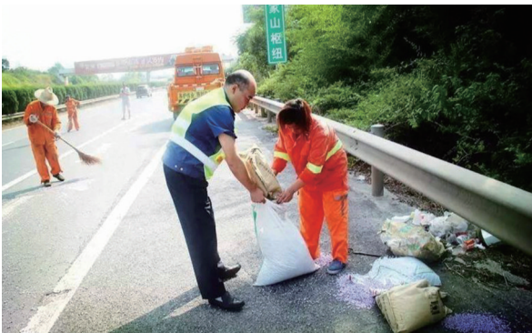
▲工作人员正在清除路面障碍物
