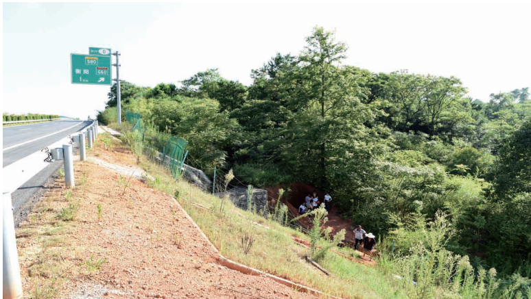
涵洞后续工程搁置,隔断了沿线村民出行的传统通道。
