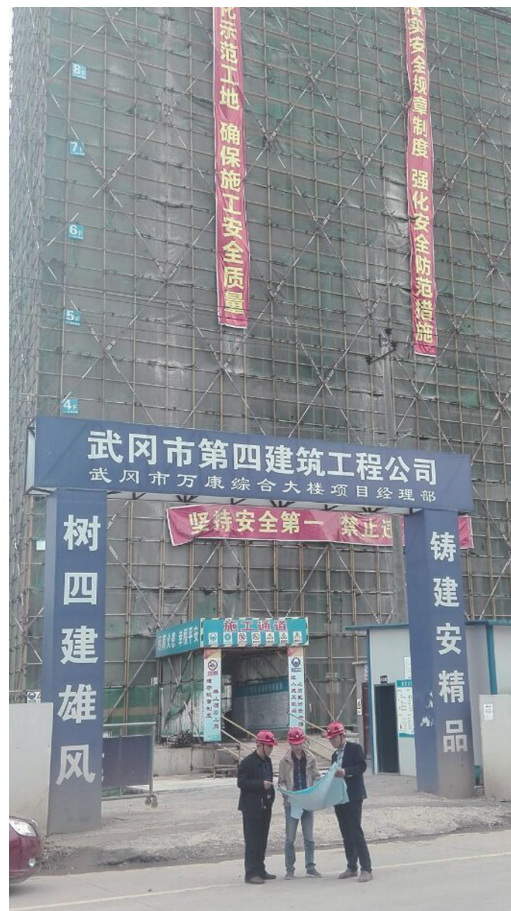
公司总经理曾正华(左一)与施工技术人员在武冈万康医院综合大楼建设工地现场指导施工
