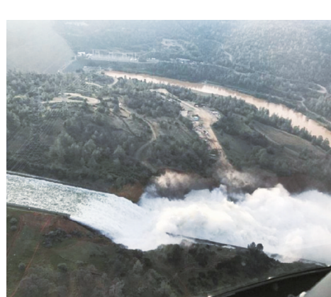
位于加利福尼亚州北部的美国最高水坝奥罗维尔水坝出现缺口。
