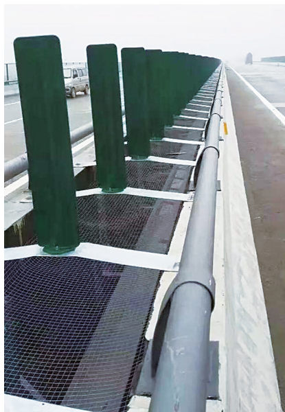
中央护栏的全新改造,使得安全性能大大提升。
