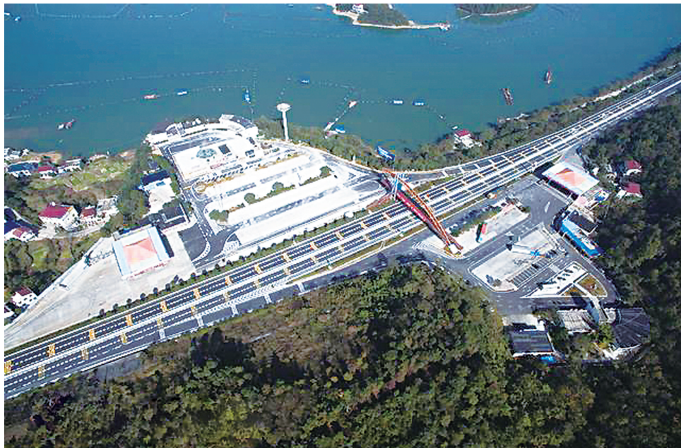
改扩建后的水府庙服务区。
