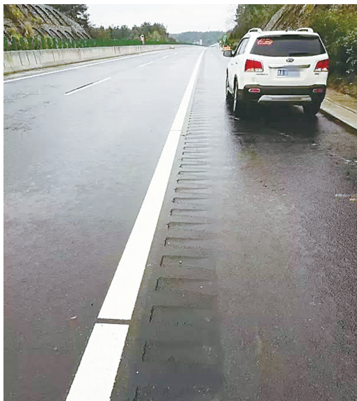
“降声带”设置在道路右侧,行车道与路肩之间。这种降声带凹凸不平,如果有驾驶员行驶偏航了,就可以立刻感受到震动,回到路中来。
