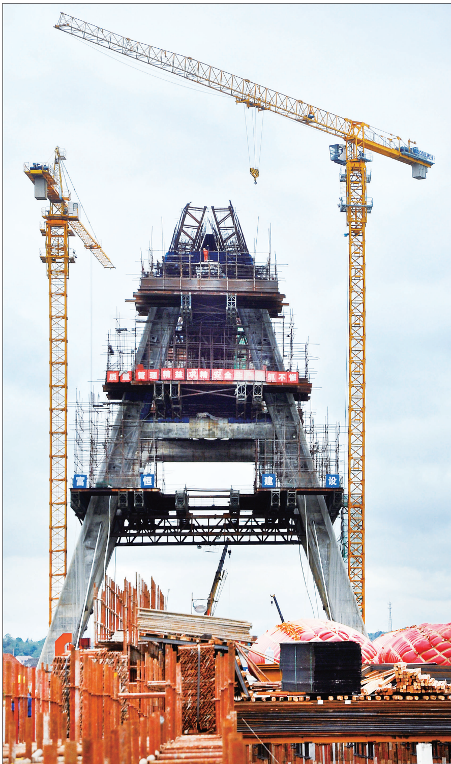
雪峰大桥采用的纵向双飞叶造型属国内首创。目前,71米高的主塔完成施工63米,北岸引桥阴历年前完成下部结构施工,南岸引桥阴历年前可全部完成施工,主梁0号与1号块即将开始挂篮施工,主梁5号块计划12月30日完工。预计全桥2017年6月底竣工通车。 申兴刚 摄
