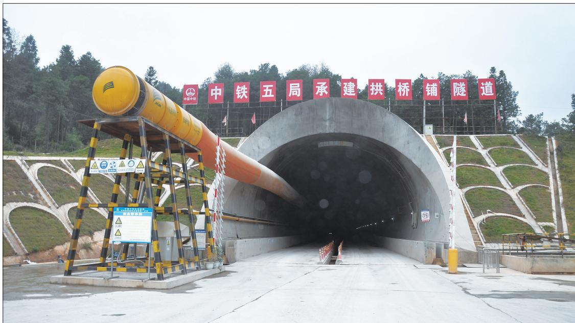
▲目前，怀邵衡铁路邵阳段进展顺利。图为南岳拱桥铺隧道，全长3886米，为单洞双线隧道，预计2017年7月30日贯通，施工工期33个月。目前，该项目建设正在顺利推进中。
