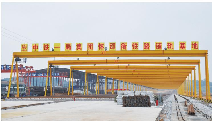
▲图为位于双清区渡头桥镇的怀邵衡铁路铺轨基地（邵阳东货场）项目。该项目涵盖枕木存放区、道砟存放区、长钢轨存放区三个建设区。随着各项工程的推进，怀邵衡全线预计年底将具备铺轨条件。
