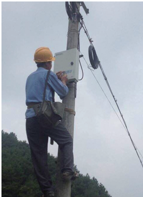
新邵电信员工顶酷暑、战高温施工。
