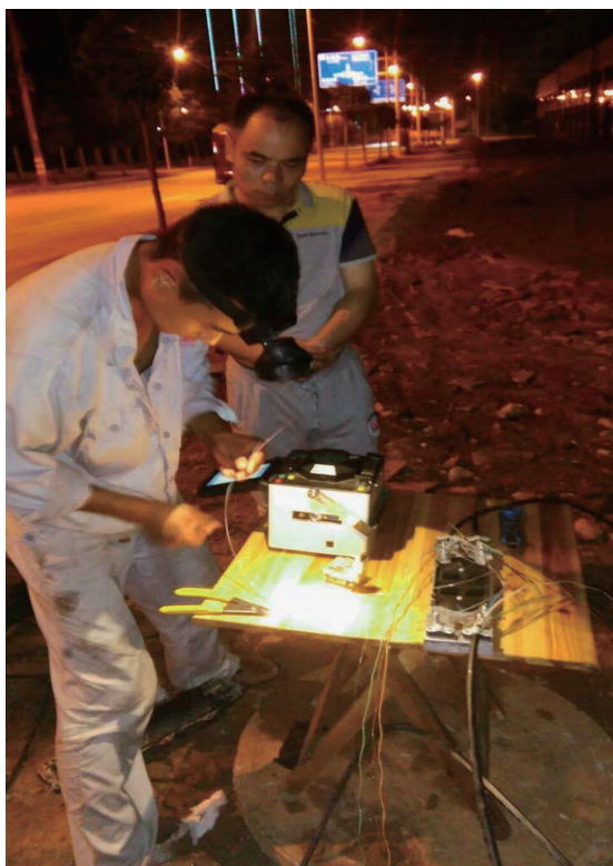
为全力推进“宽带乡村”工程,新邵电信员工起早摸黑赶进度。
