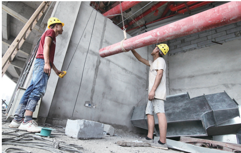
施工人员在安装体育馆消防管道
