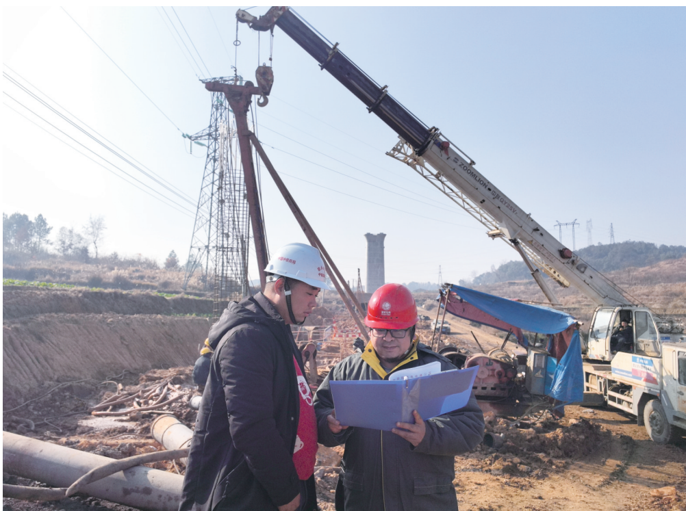
电力工作人员在施工现场宣讲安全知识。
