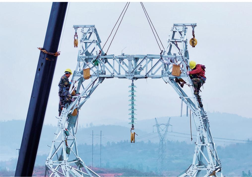
1月5日，电力施工队伍在邵东市火厂坪镇110千伏建余线36号杆组立铁塔。为进一步提升线路抗冰能力，国网邵阳供电公司抢抓晴好天气，对该线路19基水泥杆实施抗冰综合改造，为电网迎峰度冬和春节保电奠定坚实基础。
