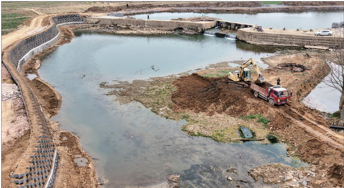
1月2日,工程车在邵阳市大禾塘街道城东社区河段加紧施工作业。入冬以来,该市利用冬季枯水期和晴好天气,加紧河道疏浚、堤坝加固和农田灌溉整修等水利基础设施建设,为农业生产和防汛抗旱提供保障。 李世近 摄
