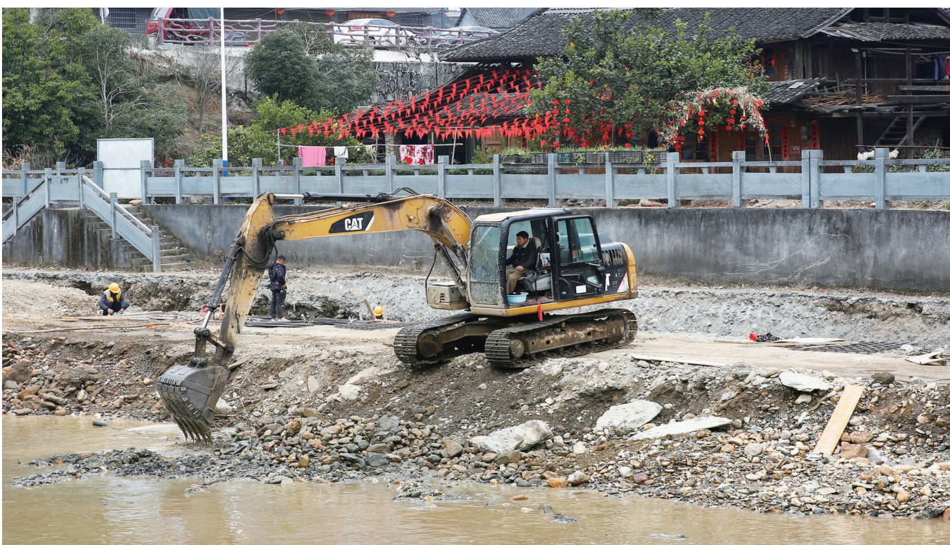
1月1日,工程车在绥宁县寨市苗族侗族乡寨市村竹河岸边加紧进行景区基础设施施工。近年来,该县大力发展文旅产业,积极推进生态保护与修复工作,坚持生态优先、绿色发展。
