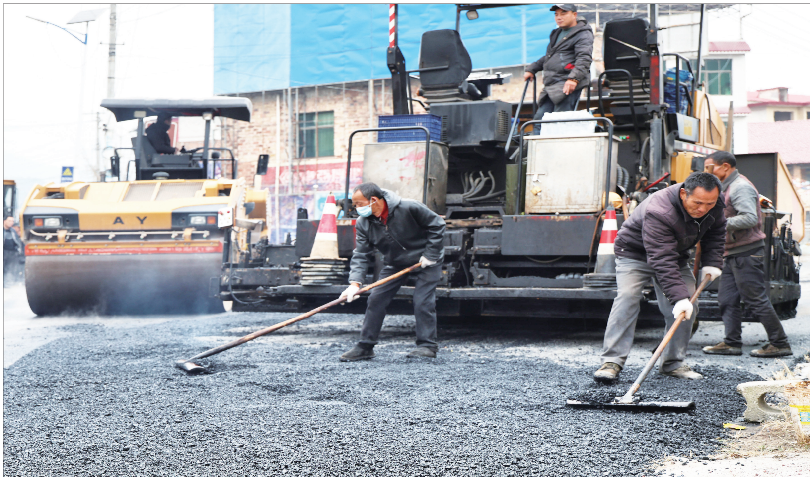
12月26日,在新邵县C560+X004孙家桥至花桥公路改建工程施工现场,施工人员正在紧张有序地进行沥青摊铺作业。据悉,该项目全线路基已顺利完成交验,计划在2025年元旦前建成通车,为城乡融合发展注入新动力。 屈凌芙蓉 唐文峰 谢长平 摄影报道
