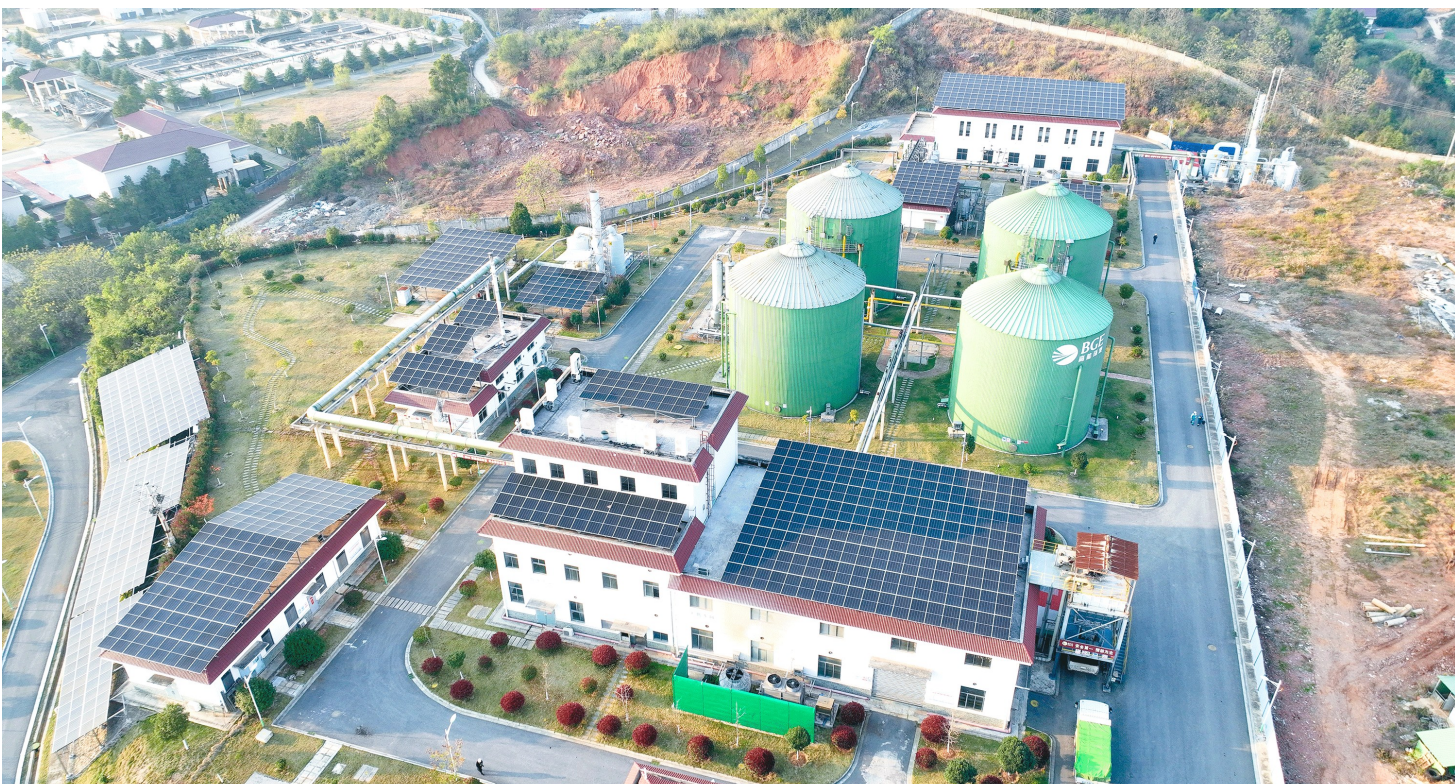
位于北塔区田江街道丰江社区的邵阳市污泥集中处置中心为进一步推进节能减排，实现绿色转型，今年9月与湖南金亦科技合作新建光伏发电4000平方米，发电量85%用于中心生产生活用电，预计每年可供电80万度，可节约成本近20万元。
