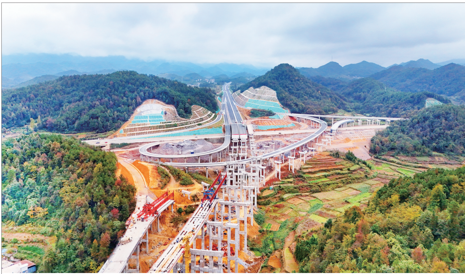
永州至新宁高速公路东起于永州市东安县井头圩镇永州西枢纽,西止于我市新宁县回龙寺镇回龙寺枢纽,线路全长64.413千米,道路为双向四车道高速公路,设计速度100千米每小时,预计今年年底通车。图为11月19日,加紧施工中的永新高速回龙寺枢纽。邵阳日报记者 申兴刚 摄
