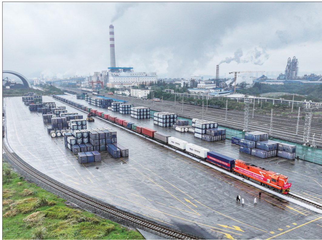
11月19日,重庆市动力电池全国铁路试运首发班列在重庆长寿渝巴专用铁路等待发车(无人机照片)。
