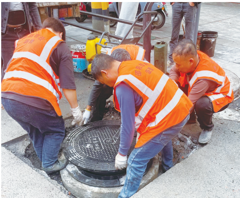
市政工作人员正在更换井盖。
