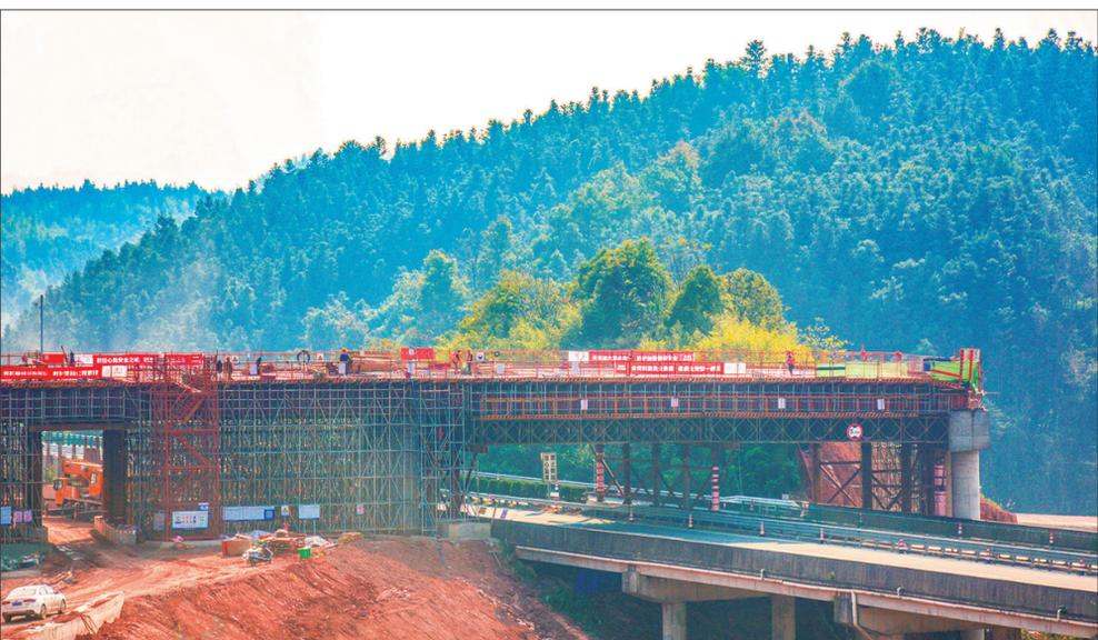
11月10日,在新宁县金石镇柳源村新新高速公路二标段终点连接洞新高速公路交会互通枢纽项目,工人们正在高架桥上施工作业。目前,该枢纽路基成型,工程进入跨路高架桥梁施工阶段。
