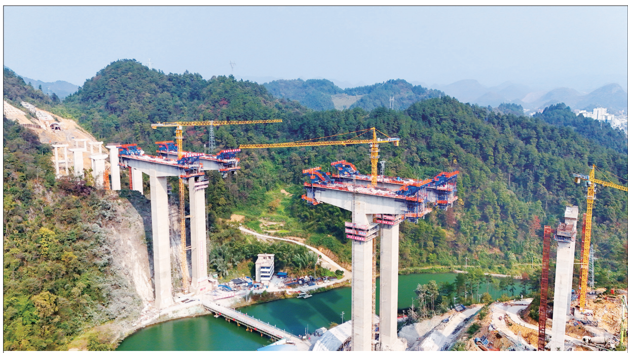
城步至龙胜高速公路邵阳段北起于城步苗族自治县儒林镇城步互通,南止于城步苗族自治县五团镇双田(湘桂界),线路全长51.82千米,道路为双向四车道高速公路,设计速度100千米每小时。目前,全线路基土石方已完成98%,桥梁桩基础完成99%,隧道总共掘进约18108.6延米。图为11月7日,加紧施工中的城龙高速。
