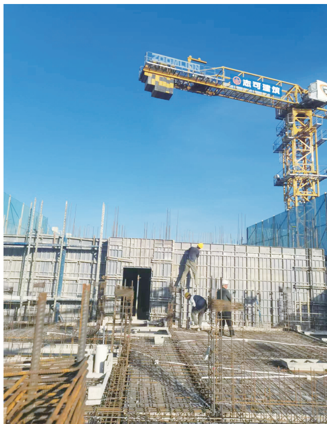
▲10月28日,汇福·白洲湾项目2号栋主体在进行第20层楼板施工
