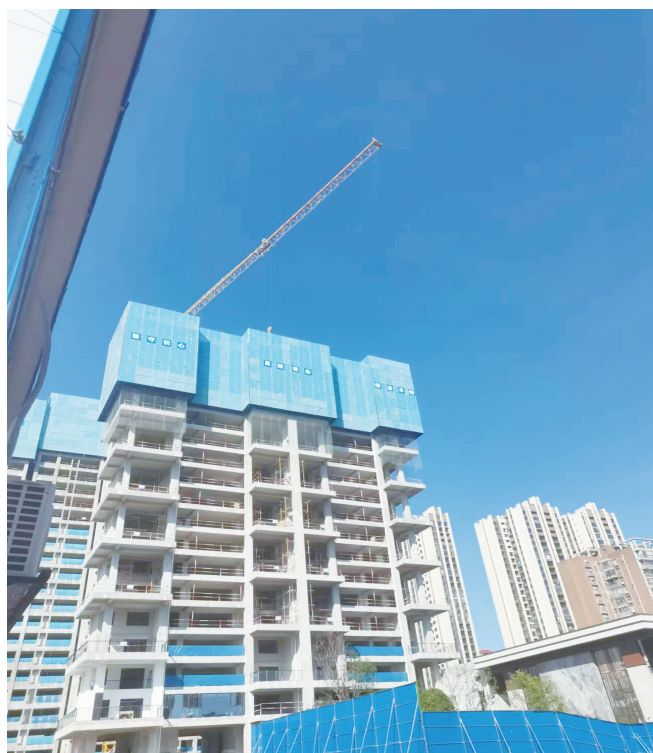
▲10月28日,汇福·白洲湾项目1号栋主体已建到25层。
