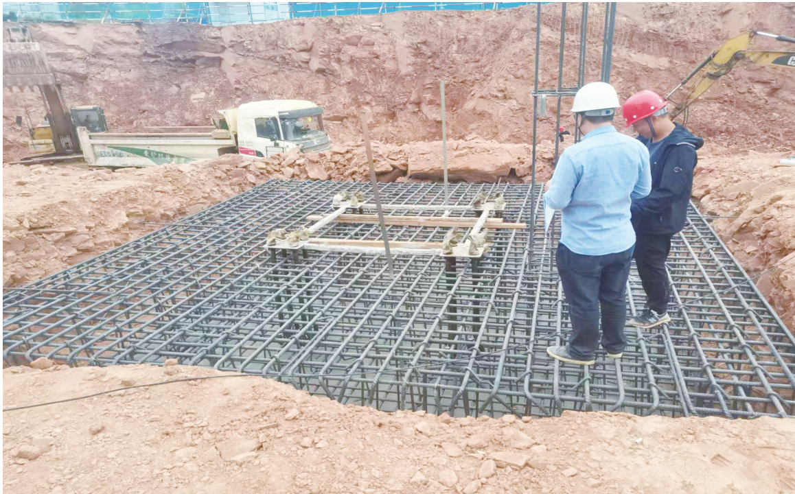
▲10月28日,汇福·白洲湾项目5号栋、10号栋正在进行基础施工。
