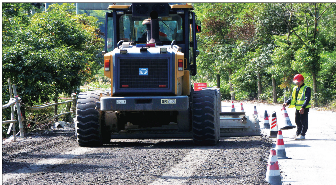
10月24日,新宁县新全公路分水段工程车在施工作业。该段公路是新宁县至广西全州交通要道。今年,该路段进行全面修复提质,确保交通安全畅通。 石国兴 摄
