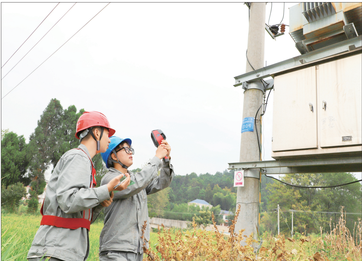
为确保配电变压器安全可靠运行,国网新邵县供电公司对新邵县小塘镇10千伏五线10号杆罗家坳2台区开展防燃爆排查专项行动。图为10月9日,该公司员工在新邵县小塘镇10千伏五线10号杆罗家坳2台区开展防燃爆巡视。邵阳日报记者 申兴刚 通讯员 谢丽英 摄影报道
