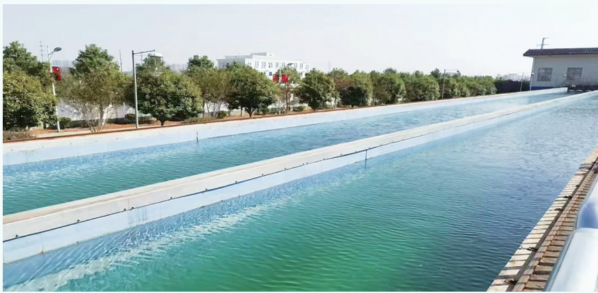
邵东市兴隆水厂沉淀池。 殷文斌 摄
