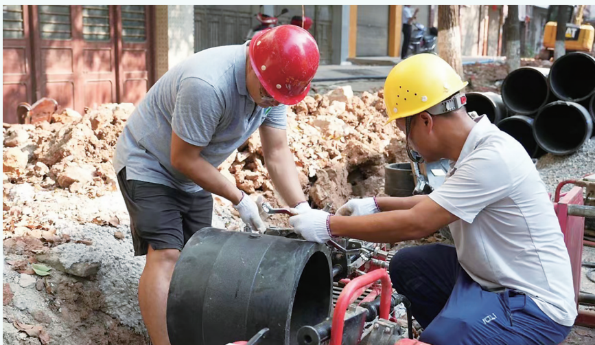
工作人员正在进行管网更换作业。 刘海 摄
