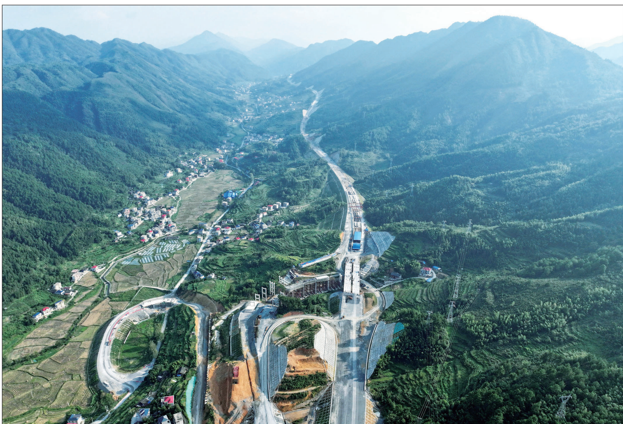
9月18日，俯瞰建设中的城步至龙胜高速塔溪互通地段。近年来，城步苗族自治县始终坚持“交通先行”战略，累计投入30多亿元，全力建设出山的“大动脉”，畅通山内的“细血管”，不断完善和提升路网结构，为乡村振兴增添了强劲动能。 严钦龙 摄
