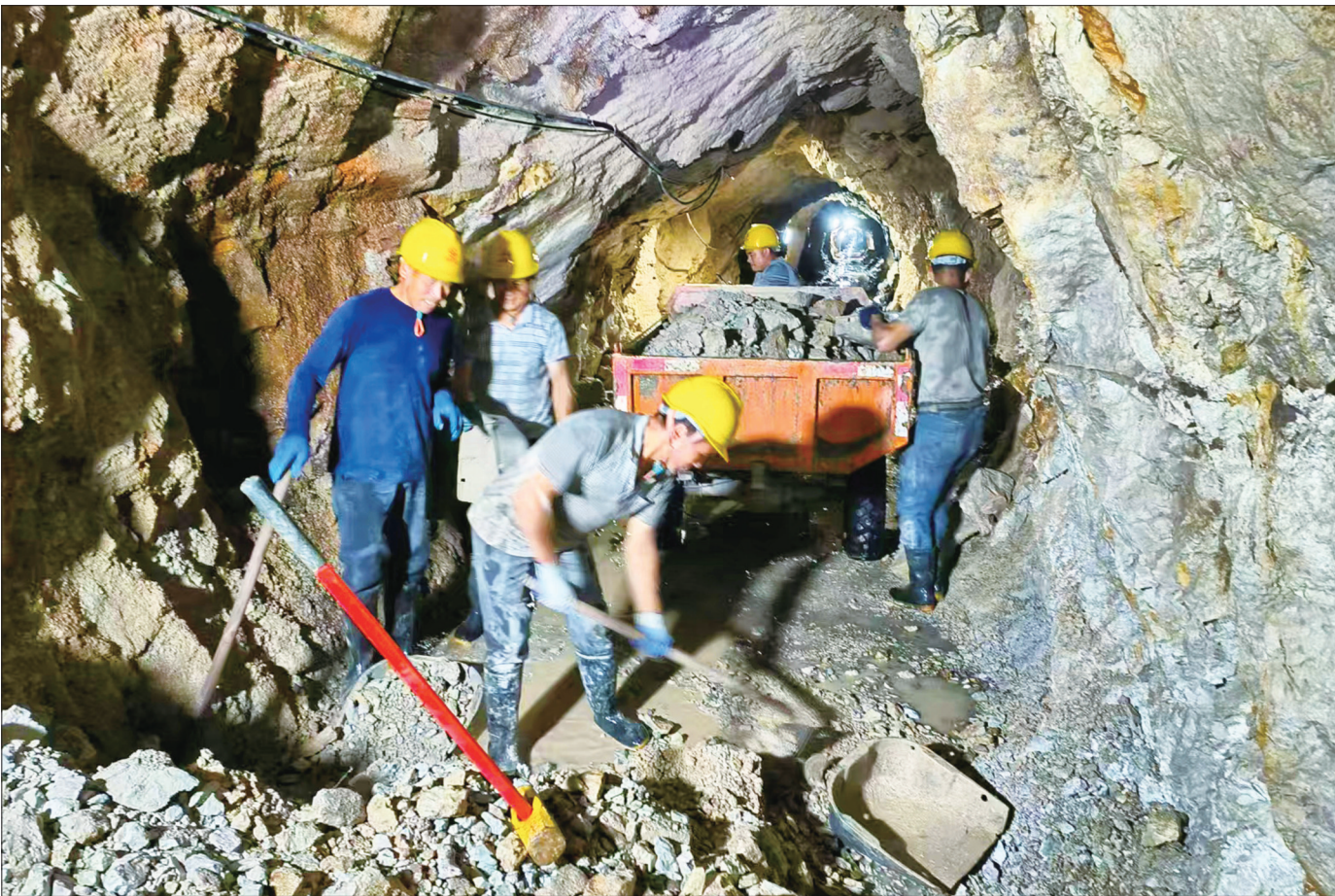
9月4日,施工人员在邵阳县尧虞塘水库除险加固工程输水泄洪隧洞加紧施工。该项目实行轮班作业,全力赶工期,预计今年年底完工。 兰巧琴 陈望远 摄影报道
