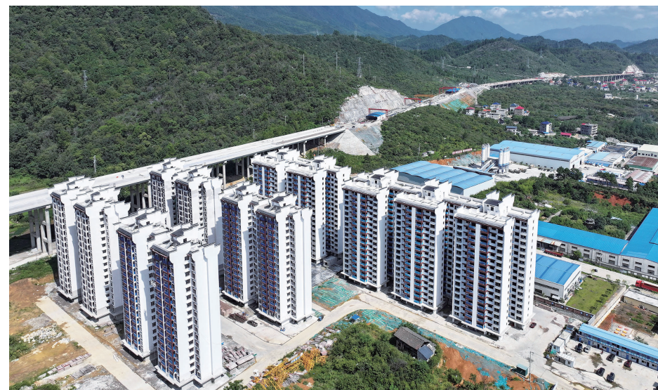
9月9日,俯瞰城步苗族自治县儒林镇白水洞保障性住房工程施工现场,建设者们正抢抓晴好天气加紧施工。近年来,该县积极推进保障性住房项目建设,不断改善提升城乡人居环境,增强人民群众获得感、幸福感、安全感。
