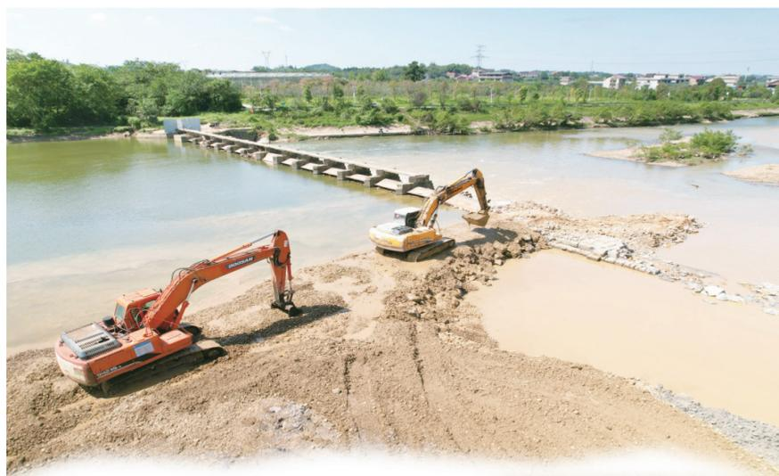
图为邵水流域王家洲水闸除险加固工程施工现场。
