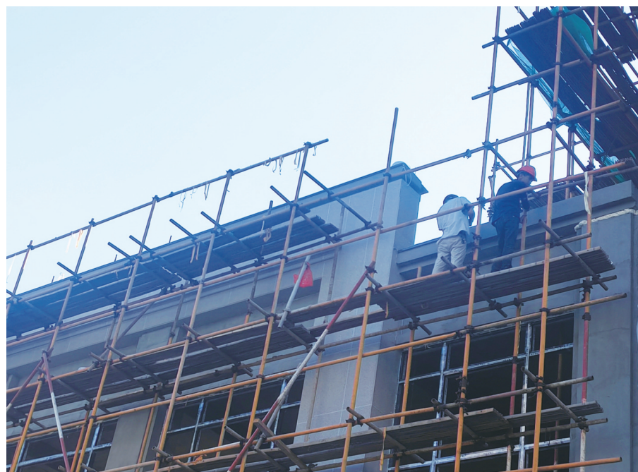
8月5日，汇福·白洲湾项目工地，工人在高空搭建脚手架。
