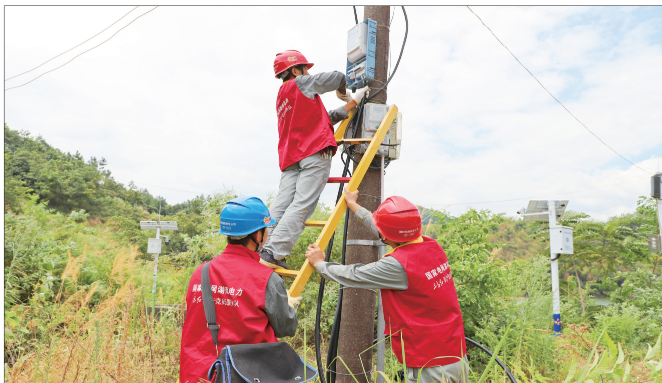
7月26日,国网新邵县供电公司员工在该县潭溪镇大马村安装抗旱用电计量装置。为确保农作物灌溉用电安全可靠,该公司及时启动抗旱保电“绿色通道”,快速为农户办理抗旱用电业务。
