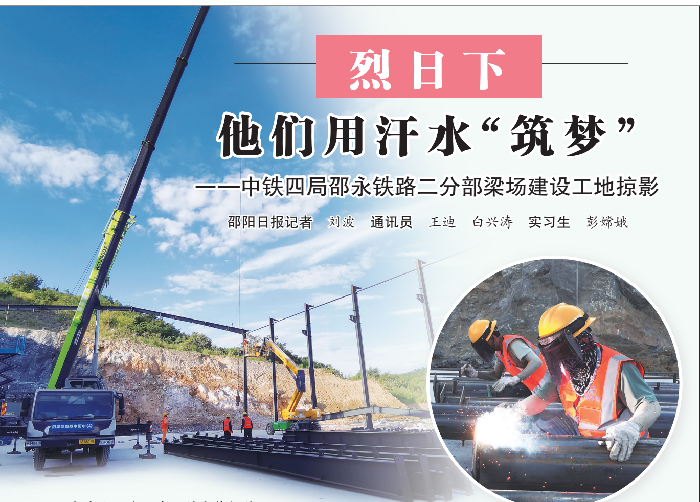
▲颜光和工友正在加紧安装钢筋加工场的钢结构大棚。
