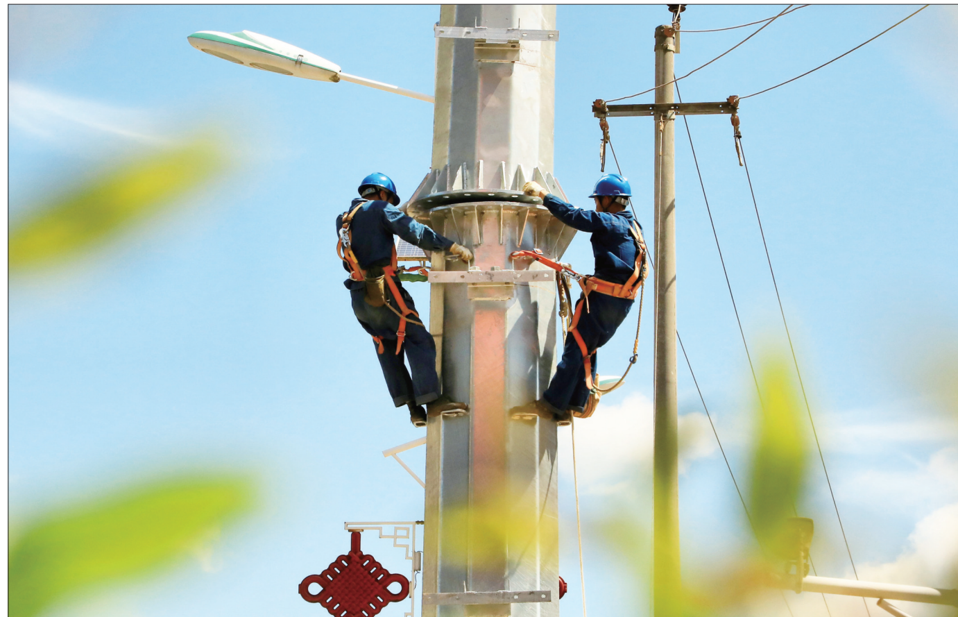
7月18日,邵阳市供电公司工作人员正在烈日下进行高温作业。近日,连续高温天气,国网邵东供电公司电力工人顶着高温,对重要供电线路、变电站进行巡视,及时开展检修和改造作业,确保电网安全运行和电力可靠供应。李世近 摄
