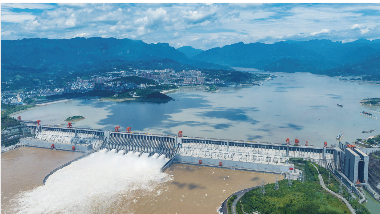
三峡水库 加紧泄洪腾库
