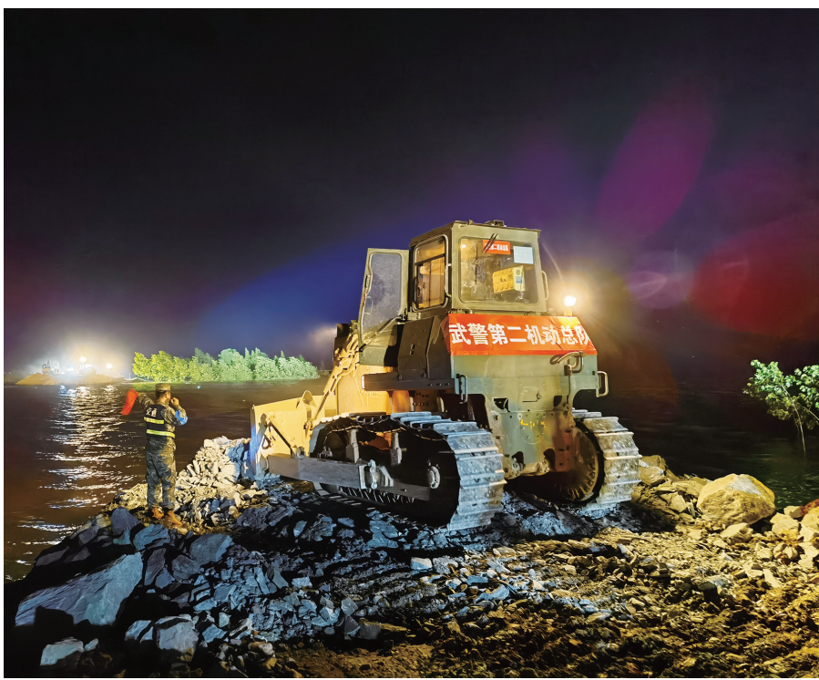
7月7日凌晨,在湖南省岳阳市华容县团洲垸洞庭湖一线堤防决口处,武警部队官兵操纵工程机械封堵决口。新华社记者 李秉宣 摄
