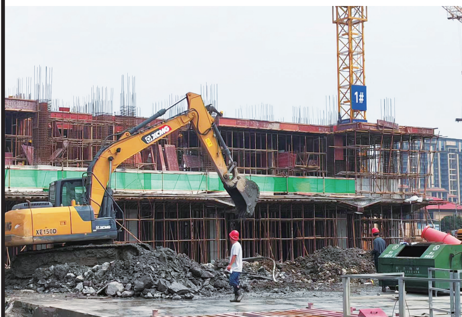
▲5月7日,工人们正在该项目1号栋加紧施工。
