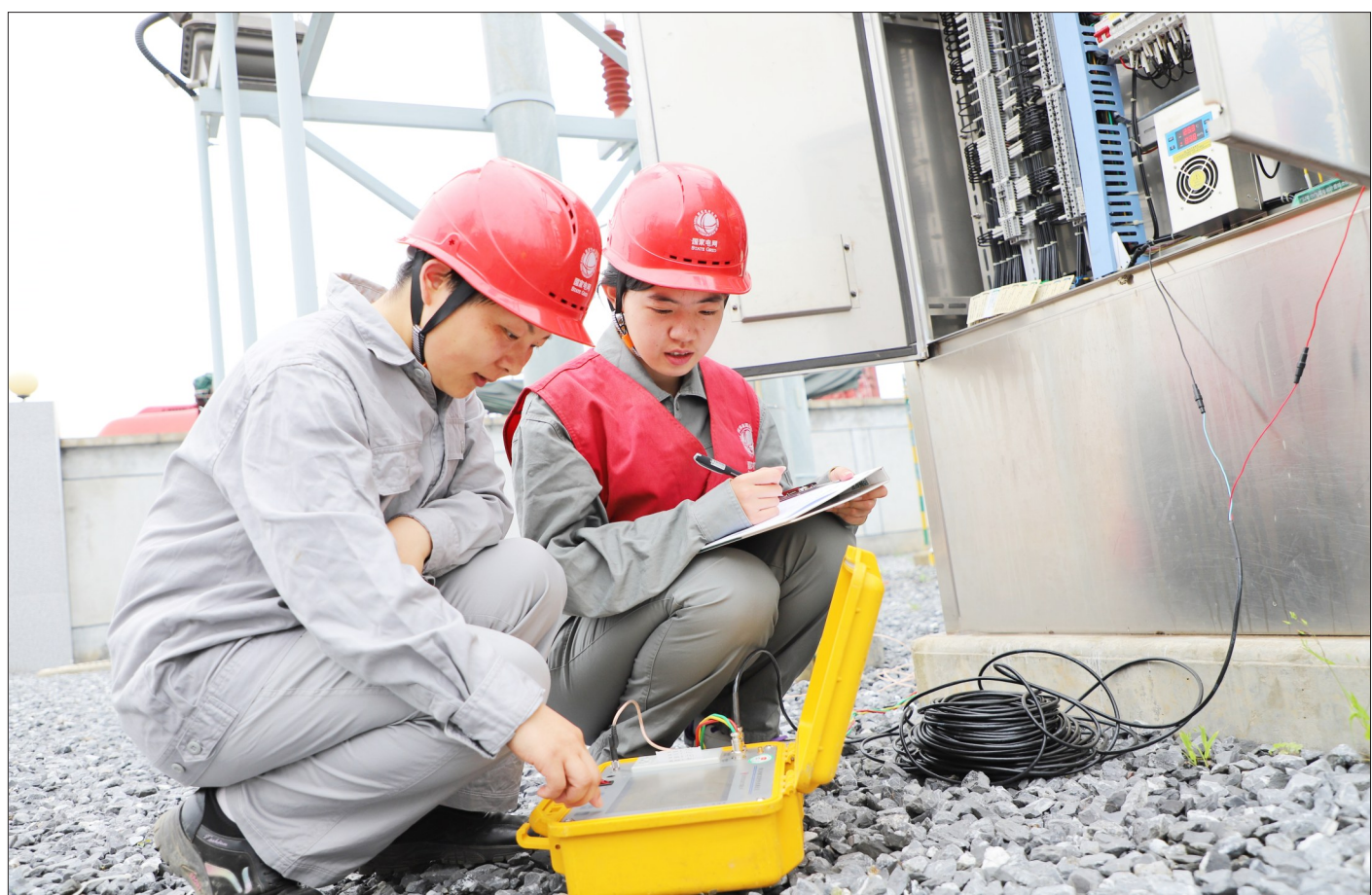
5月8日,国网新邵县供电公司变电运检班工作人员对35千伏园艺变电站开展防雷整治,提高电网抵御恶劣天气的能力,确保辖区电网安全可靠稳定运行。目前,该班组已完成对辖区11座变电站的避雷器阻性电流测试。
