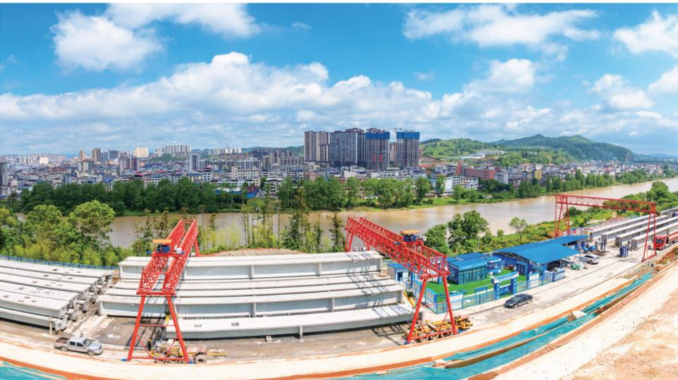
5月5日,雨后转晴,在新宁县金石镇观瀑村新新高速公路二标段高架桥箱梁预制场,工人们正在忙着用大型吊车吊运箱梁。
