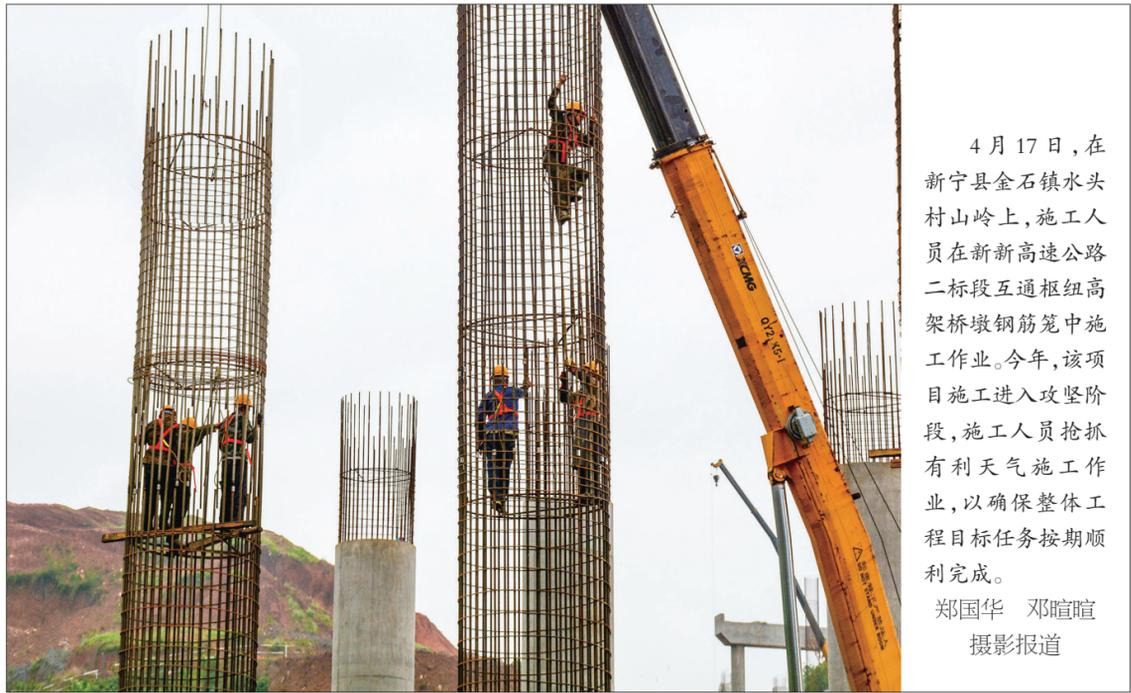
4月17日,在新宁县金石镇水头村山岭上,施工人员在高新高速公路二标段互通枢纽高架桥墩钢筋笼中施工作业。今年,该项目施工进入攻坚阶段,施工人员抢抓有利天气施工作业,以确保整体工程目标任务按期顺利完成。
