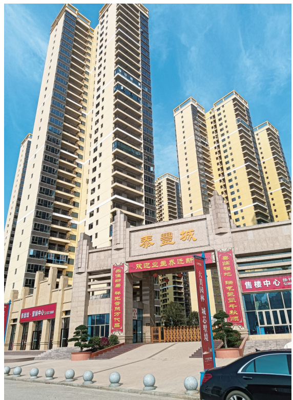
邵东国际商贸城(二期)——泰丰城项目是省、市重点项目,项目占地面积13.87公顷,总建筑面积约69万平方米。项目建筑物色调温馨和谐,设计突出人与自然相结合,科学合理。
