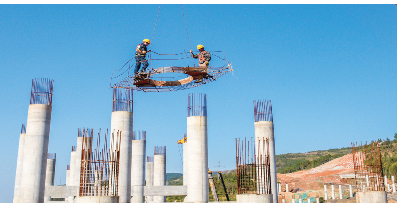
3月11日，新宁县金石镇水头村新新高速公路二标段互通枢纽高架桥墩上，工人在高架桥墩上施工作业。当前，该段公路全线抢抓天时，加紧施工作业。郑国华 邓喧喧 摄影报道
