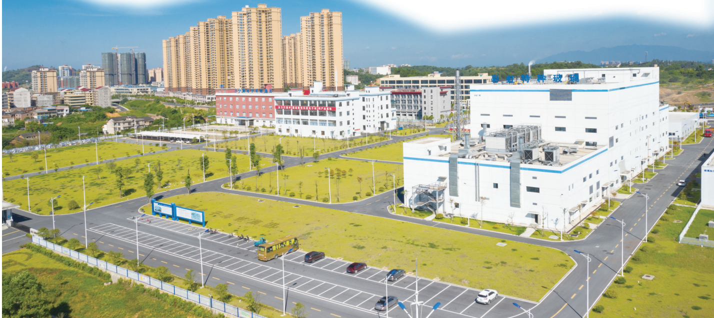
图为彩虹集团(邵阳)特种玻璃有限公司一角。 申兴刚 摄
