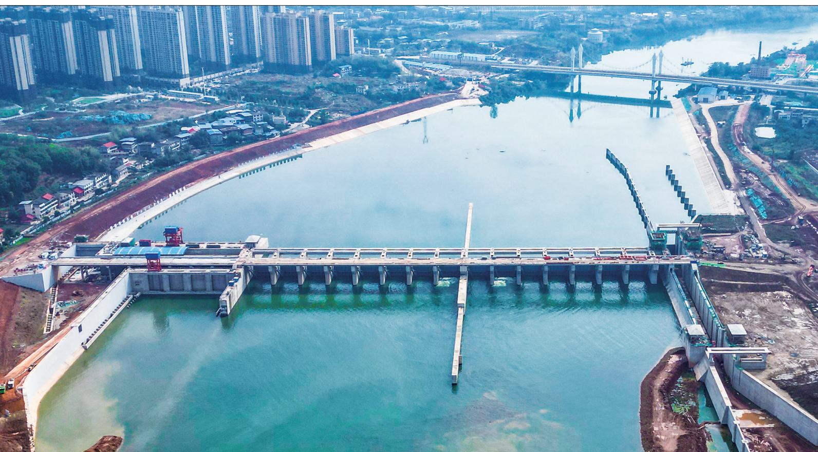
2023年10月28日上午，犬木塘水库枢纽工程首台水轮发电机组1号机组启动，标志着犬木塘水库枢纽工程按期实现关键节点目标，开始发挥蓄水发电综合功能。
